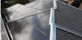
Eine hybride 2.7 kWp-PV-Anlage erzeugt 3'210 kWh /a Strom und liefert zusammen mit den Naturschleferkollektoren (Bild 1) rund 10'000 kWh /a Wimme.
